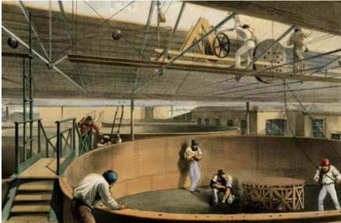
Figure 2 Résevoirs de l'usine Telcon - 1865
