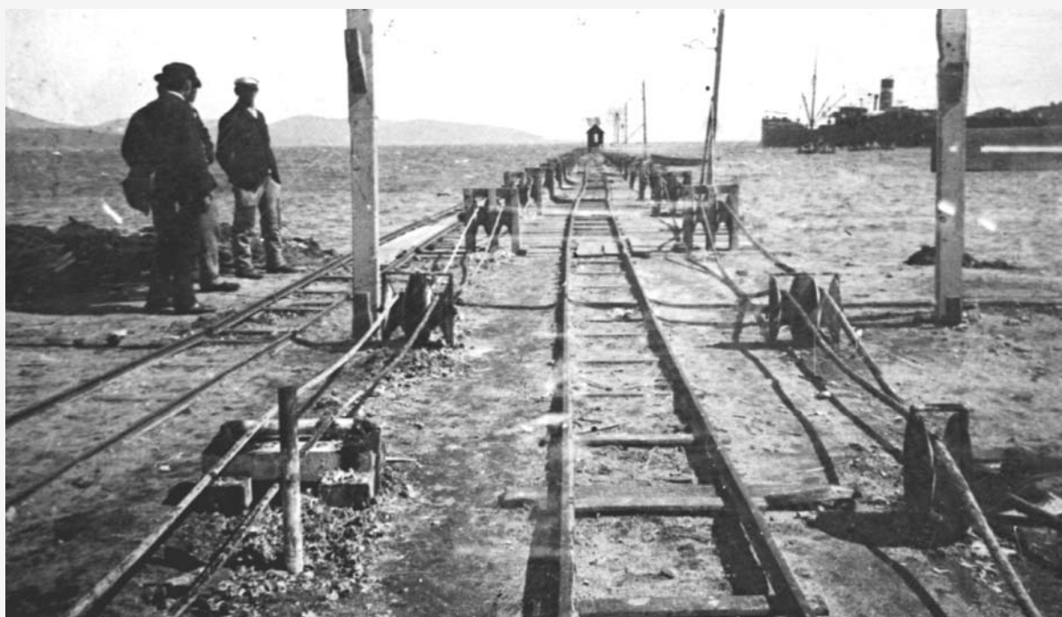
Appontement de la câblerie
