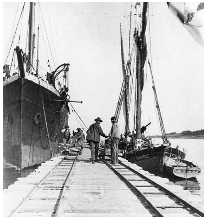
Appontement de la câblerie, 1905 (Coll. particulière)
