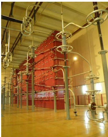
Ancienne salle des valves
