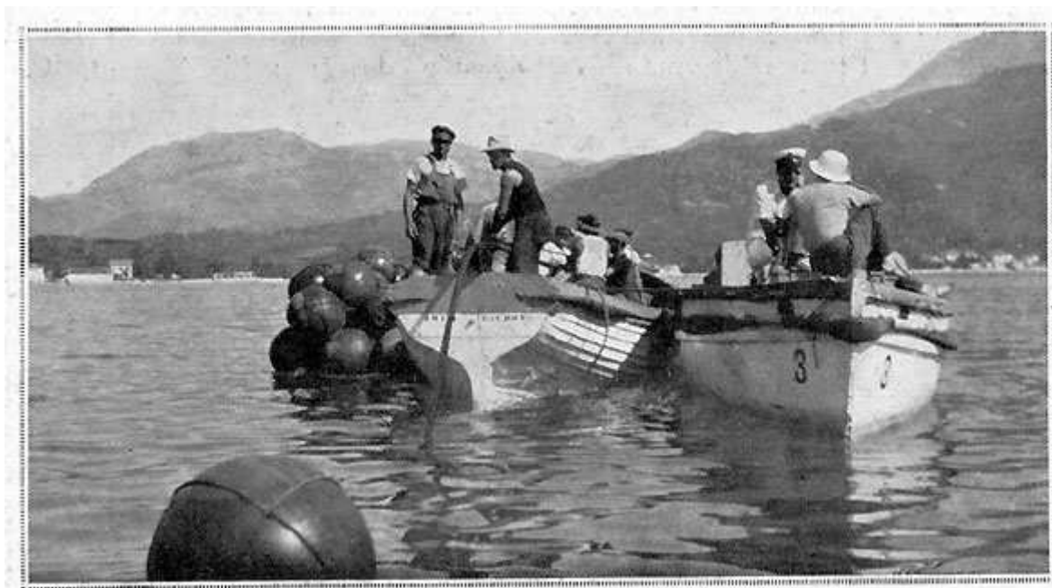
En rade d'Hercegovi-Igalo : les ballons qui maintenaient le câble à la surface sont ramenés et le câble est immergé.
